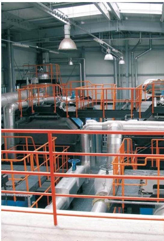
Blok energetyczny (widok z góry)
