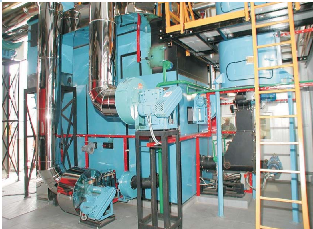
Palenisko do spalania drewna poprodukcyjnego o mocy 1 MW
