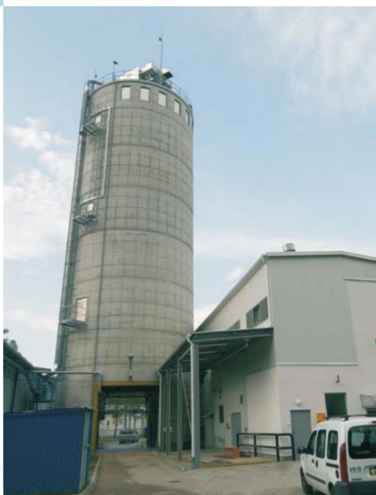
Kotłownia (widok z zewnątrz)
