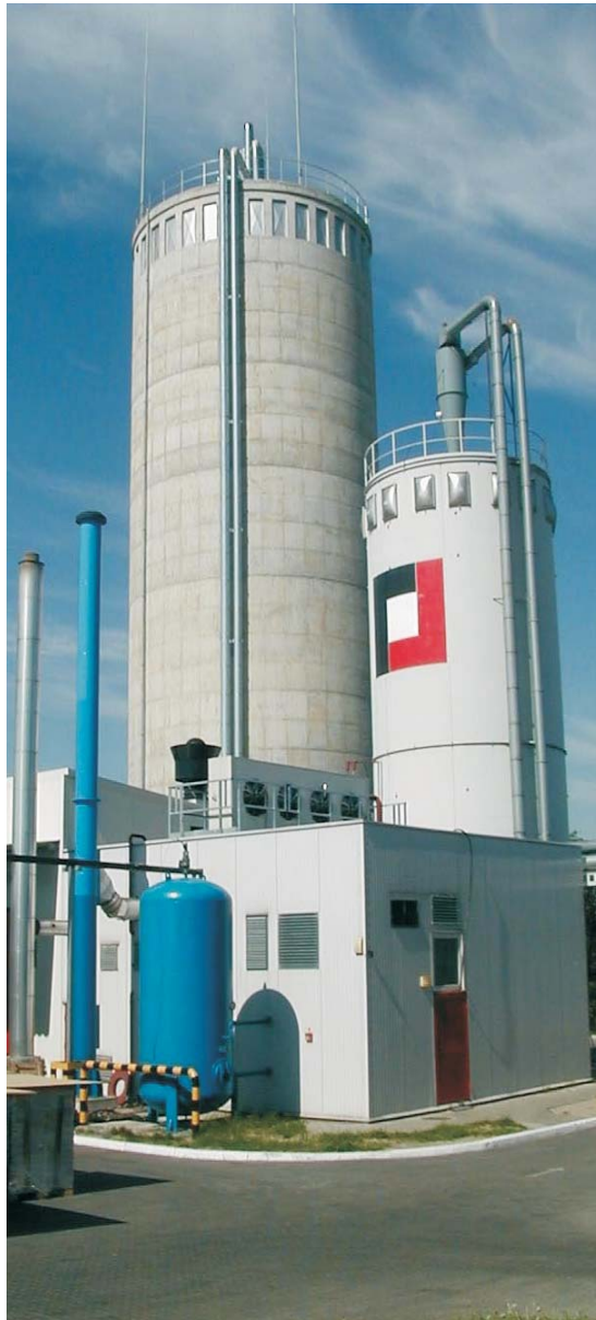
Kotłownia 1,0 MW z silosem do składowania paliwa
