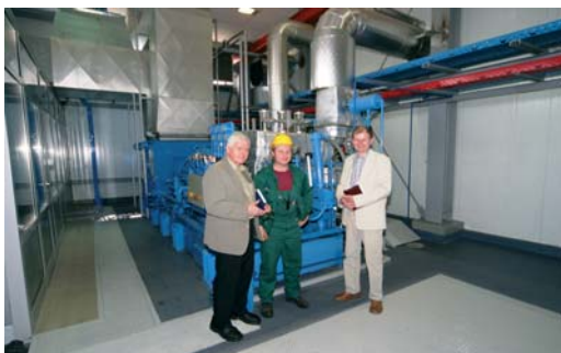
Turbogenerator 2,65 MW
