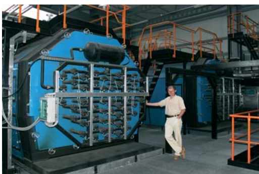
Kocioł parowy z oczyszczaniem, 32 bar nadciśnienia
