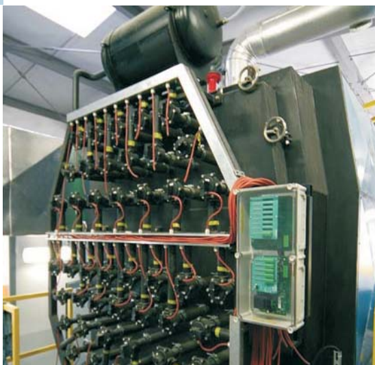
System czyszczenia płomieniówek
